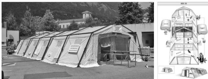
**Figura 9-7.** Módulo de descontaminación.
